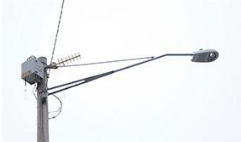
Figura 7 – Luminária Led com comunicação RF<sup>18</sup>
