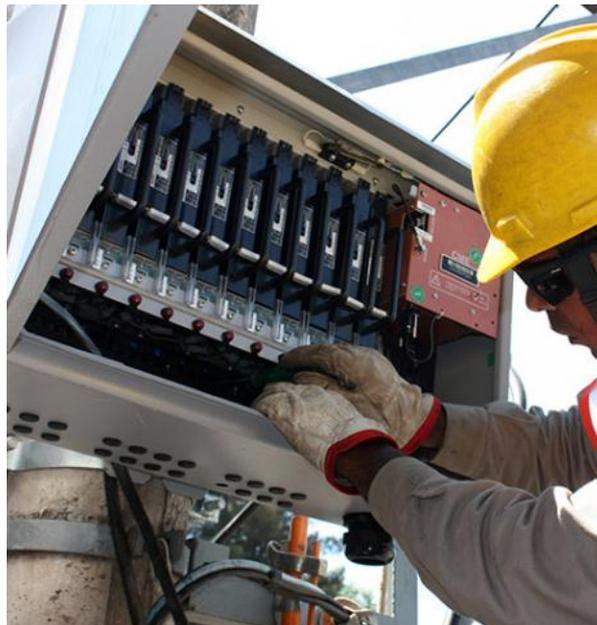
Figura 20 – Caixa concentradora de medição<sup>43</sup>
