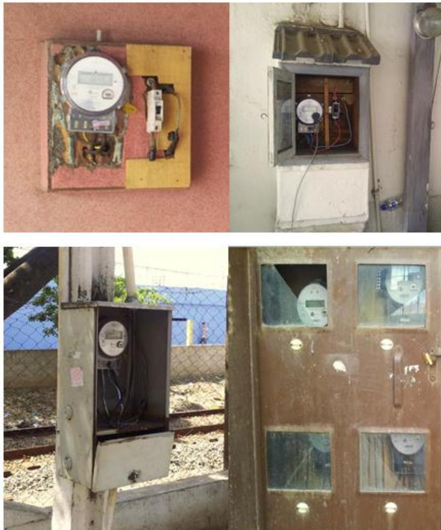
Figura 19 – Instalações típicas de medidores (arquivo pessoal)
