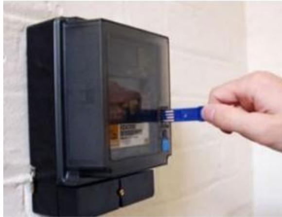
Figura 11 – Medidor pré-pago com recarga via chave eletrônica<sup>30</sup>
