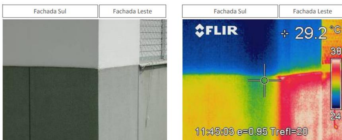
Figura 22 - Termografia de fachadas sul e leste.
