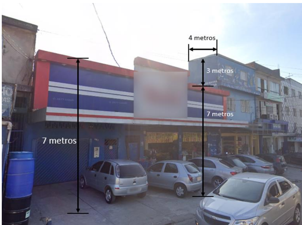
Figura 3.5 – Fachada do supermercado
