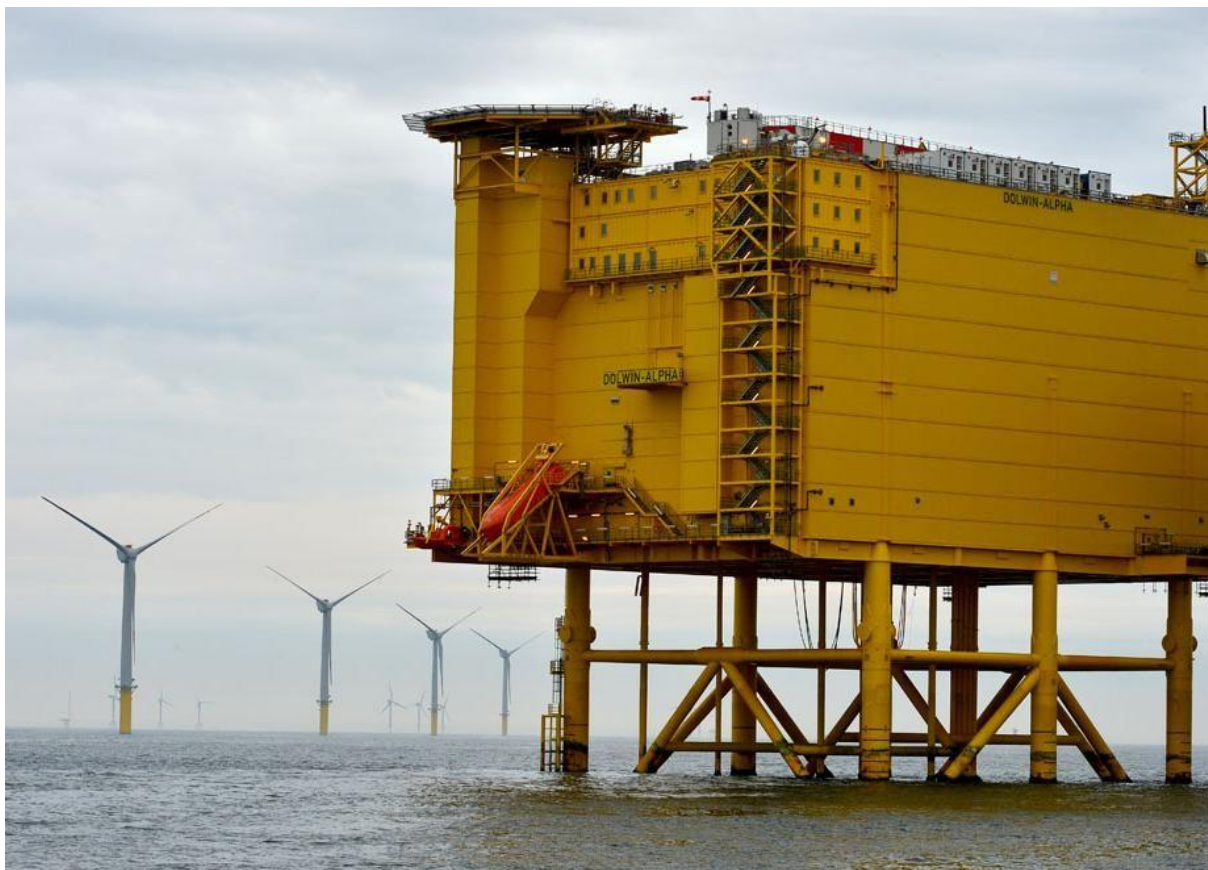
Figura 6.3 — Subestação offshore DoIWin Alpha
