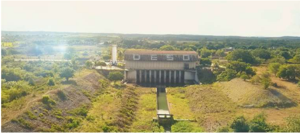
Figura 4.5.11 – Estação Elevatória de Água Bruta do Rio São Francisco Fonte – (Vitalux Ecoativa)
