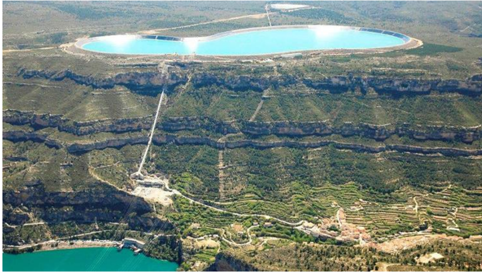
Figura 2 - Hidrelétrica resersível e seus componentes básicos, UHR La Muela, grupo Iberdrola, Espanha
