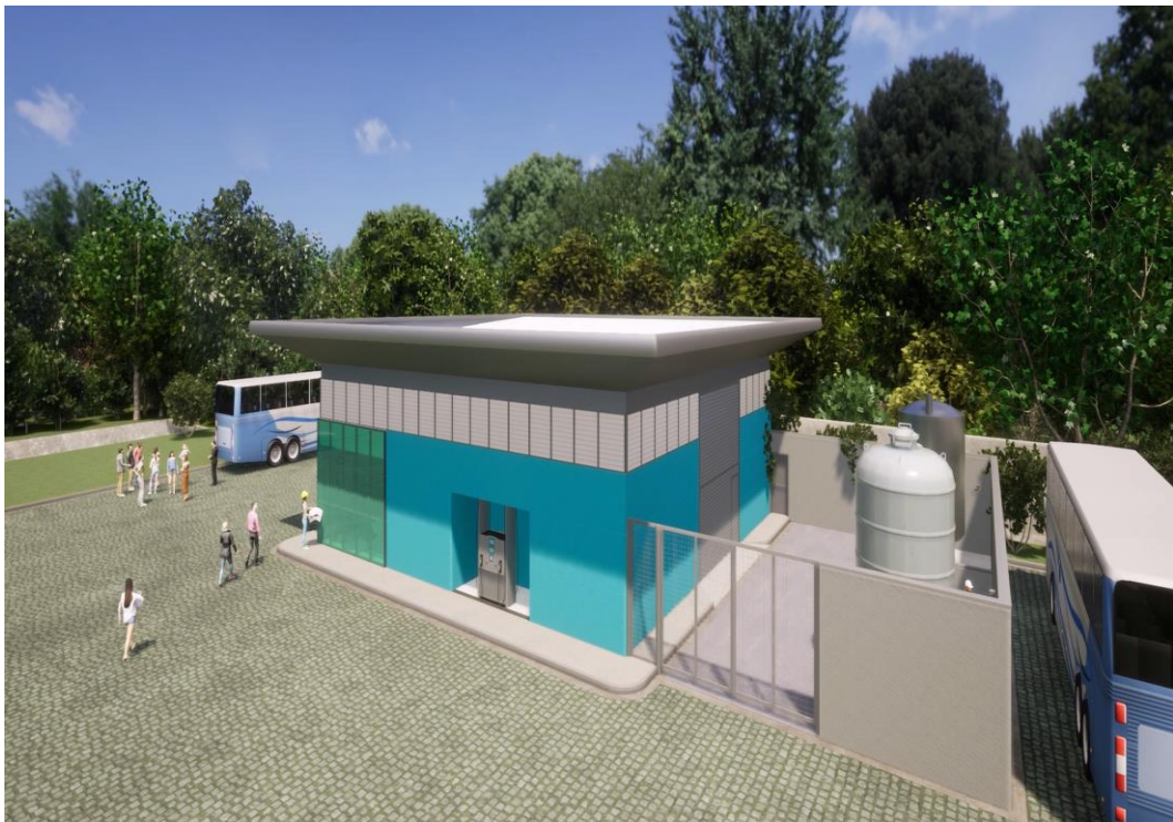
Figura 38 – Estação H 2 da USP Finalizada
