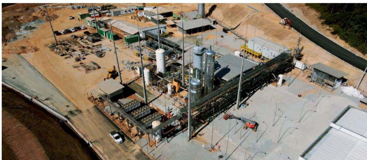
Figura 3.3 - Vista aérea da planta de produção de biometano em construção na CVTA Caieiras.
